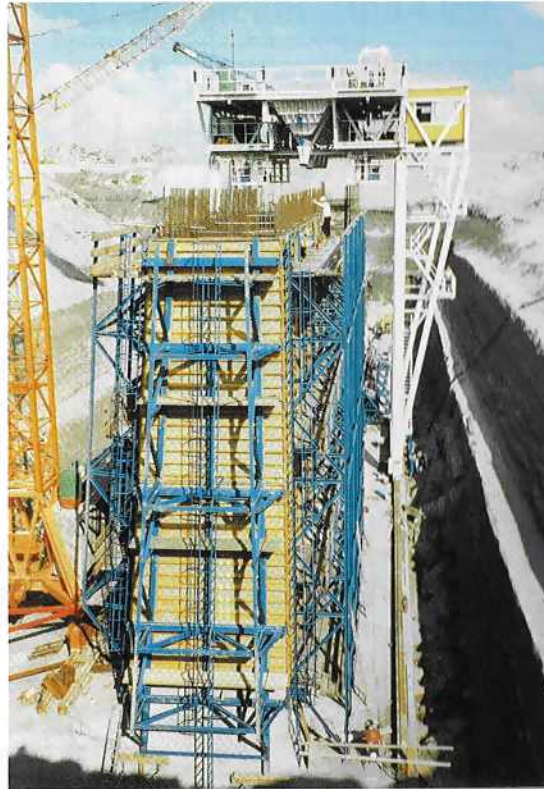
6 | Portaalkraan voorzien van 5 storttrechters (foto links)
