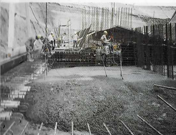
4 | Storten voetplaat met grijper, verdichten met onder meer een bemande trilmaschine foto's: Rob van Berkel
