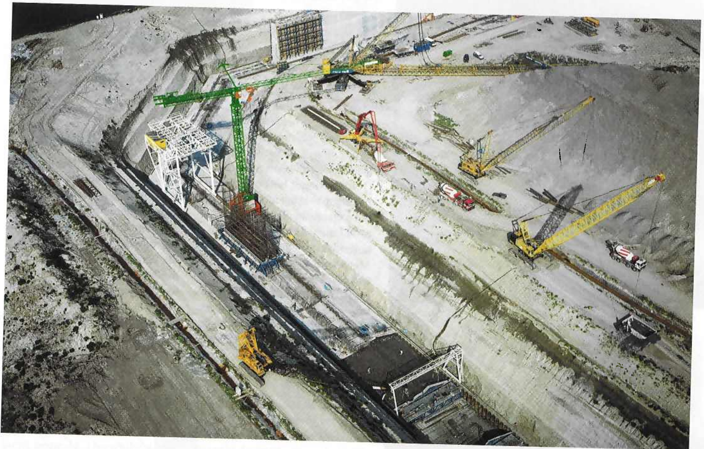
1 | Overzicht kademuur in aanbouw: van voetplaat (onder) tot wand (boven) foto: Guido Coolens, Antwerpen
