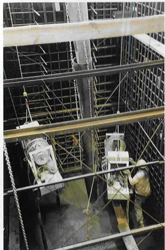
8 | Wandstort met hangende trilnaalden
